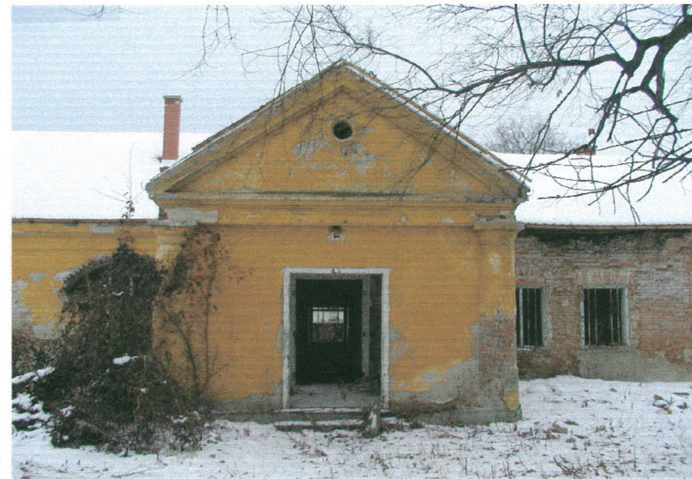
A klasszicista szárny déli - eredetileg feltehetően nyitott - udvari bejárata, ami mára már a sorozatos átalakítások következtében zárttá tettek, s a kapcsolódó XX. századi toldás....
